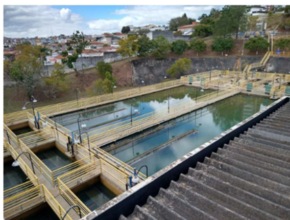
Figura 7 - Vista geral de um dos módulos de tratamento
