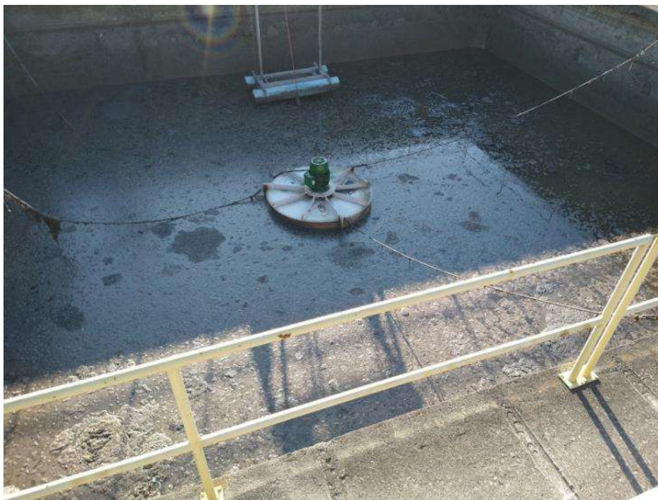
Figura 32 - Vista de um dos tanques de aeração/decantação. Destaque para o aerador mecânico superficial e para a estrutura flutuante de coleta de sobrenadante
