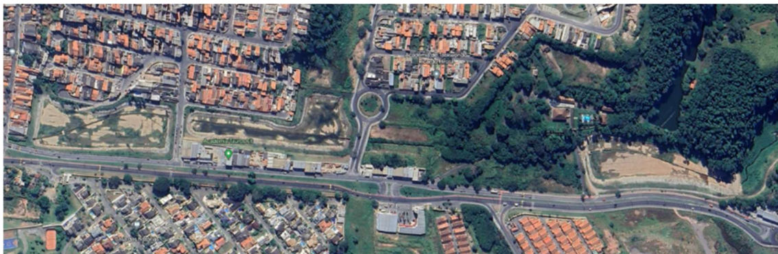
Figura 55 – Bacia de Detenção em Jacareí, SP
