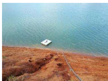
Figura 14 - Vista da Captação Flutuante (ETA I)
