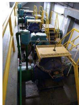
Figura 6 - Vista do poço seco e conjuntos motobomba, do tipo bipartidos, da captação principal
