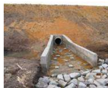
Figura 60 – Lançamento na Rede de Macro drenagem
