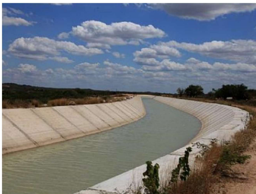
Figura 54 – Exemplo de Canal Revestido
