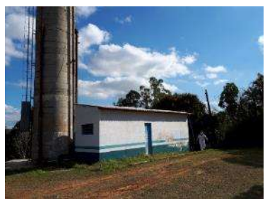
Figura 17 - Vista geral do nicho de abrigo do painel de energização e acionamento das motobombas da captação da ETA
