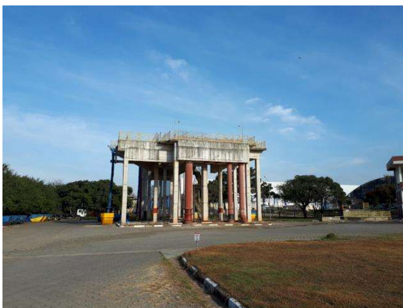
Figura 22 – Vista geral da unidade de tratamento preliminar
