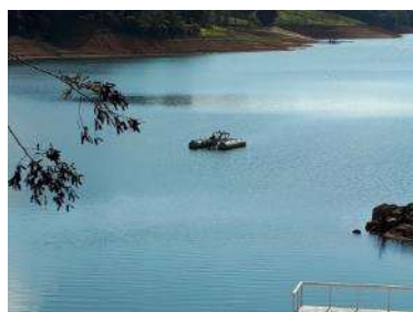
Figura 18 - Vista da captação flutuante, primeiro estágio de recalque (ETA III)
